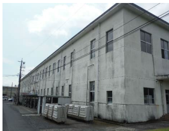
【現状施設の例(庁舎)】
