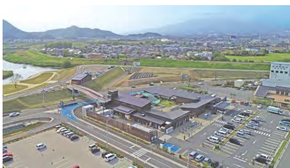
“Michino-eki,” “Kawano-eki” PFI project (Kannami, Shizuoka)
