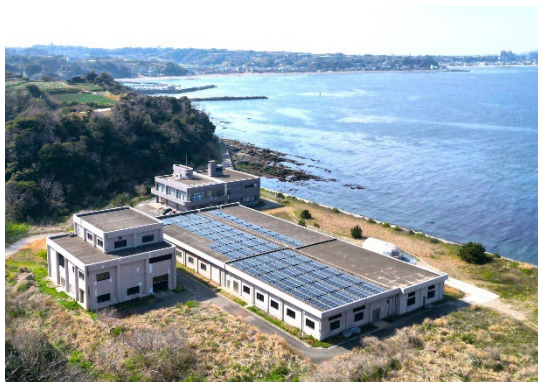
東部浄化センター（遠景）
