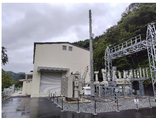
日野川第一発電所（外観）
