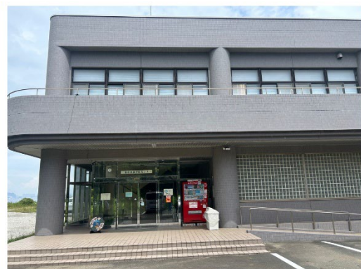
東部浄化センター（近景）
