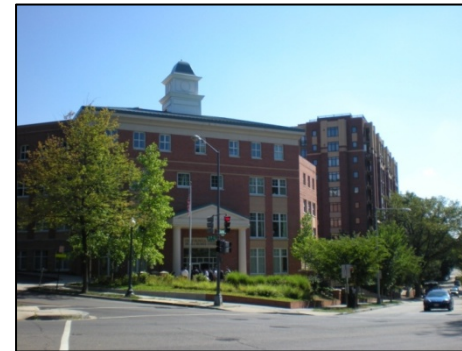
PPEAの先行例となったワシントンDCのオイスタースクール(小学校)更新プロジェクト
