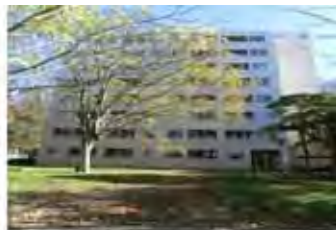
一の矢31号棟北側
