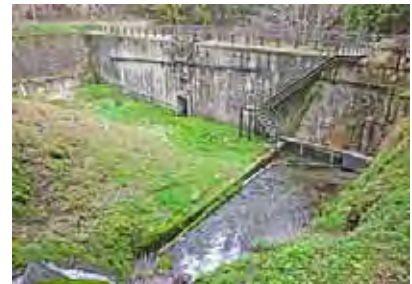
湧水付近に明治時代に築かれたダムが残る
