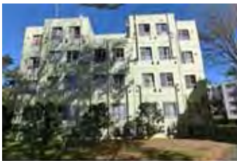
一の矢8号棟南側
