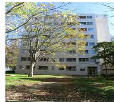
一の矢31号棟北側
