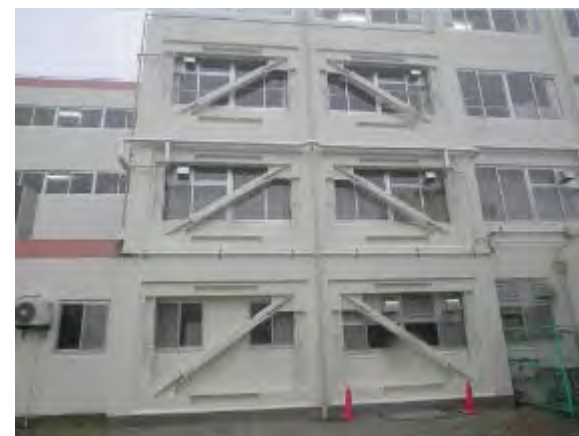
事業者提案改修工法
