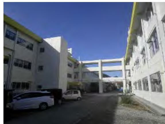
2棟を単年度で施工
