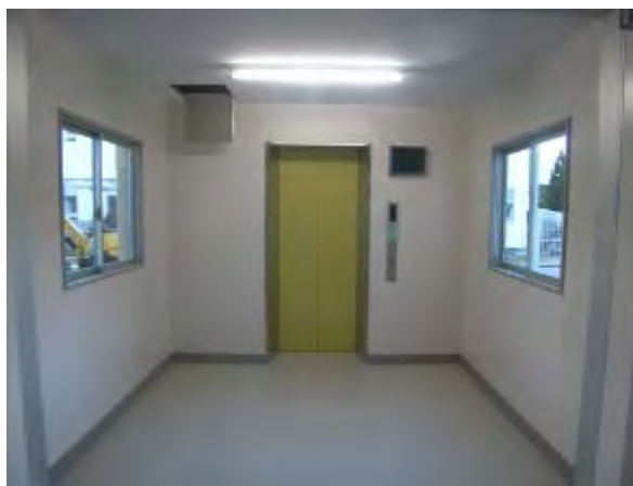
エレベーター設置
