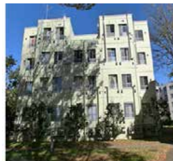
一の矢8号棟南側
