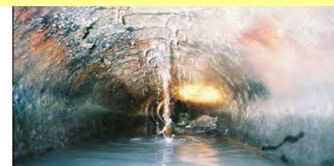
管路のクラック、腐食等による浸入水
