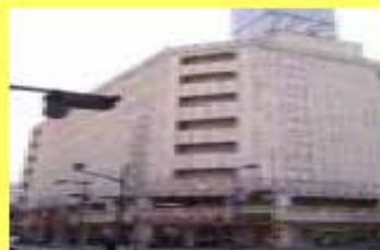
空きビルの改修 コンバージョンの支援
