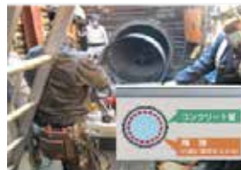
例：管路の耐震補強
