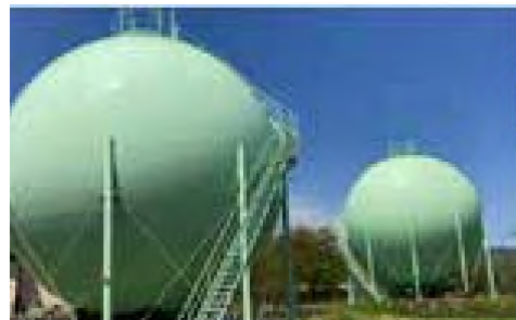
志浄水場、ガス水道管理センター
