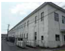
【現状施設の例（庁舎）】
