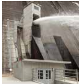
【発電設備の新設・増強】
