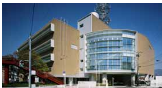
消防庁舎外観
