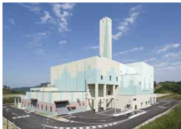
施設外観（南西側より）
