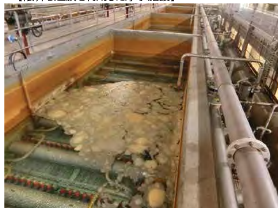
【限界ろ過膜を利用した浄水施設】
