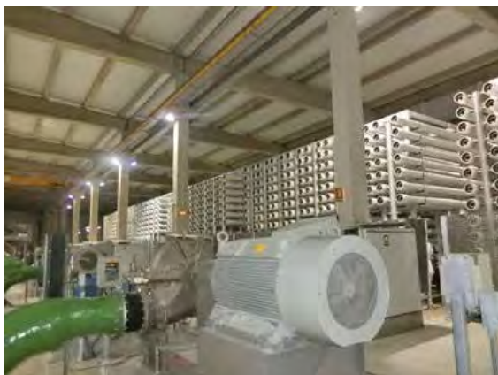
【逆浸透膜を利用した浄水施設】
