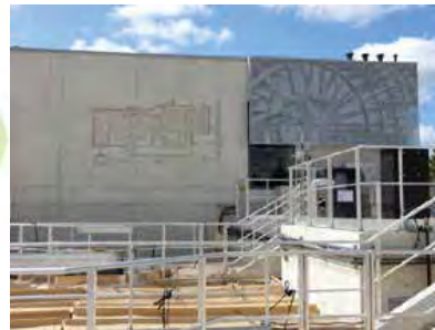
【石灰除去施設の外観】
