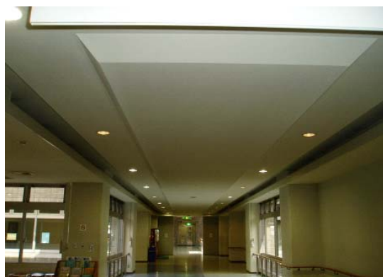
○廊下照明のセンサ化(研修棟2階)
