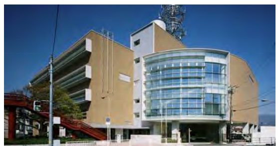
消防庁舎外観
