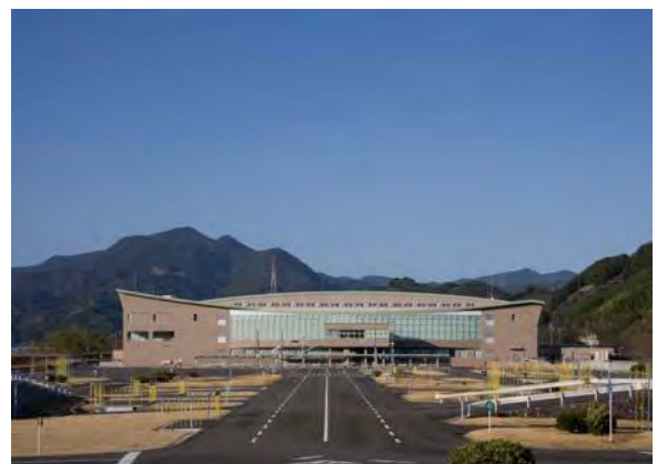
中部免許センター外観
