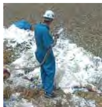
樹脂系泡被覆材の活用
