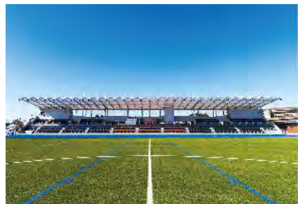
柳島スポーツ公園整備事業（神奈川県 茅ヶ崎市）
