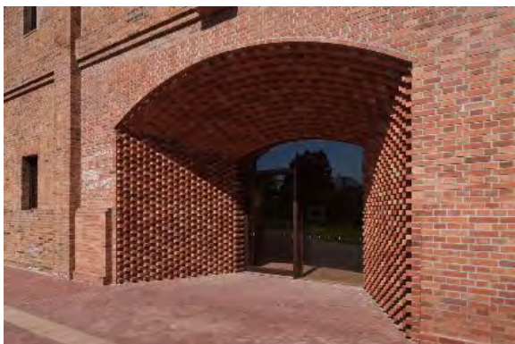
▲建物入口の煉瓦積
