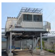
▲高床式の熱源供給棟
