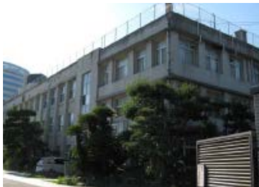
演習の題材 (旧内山下小学校跡地)
