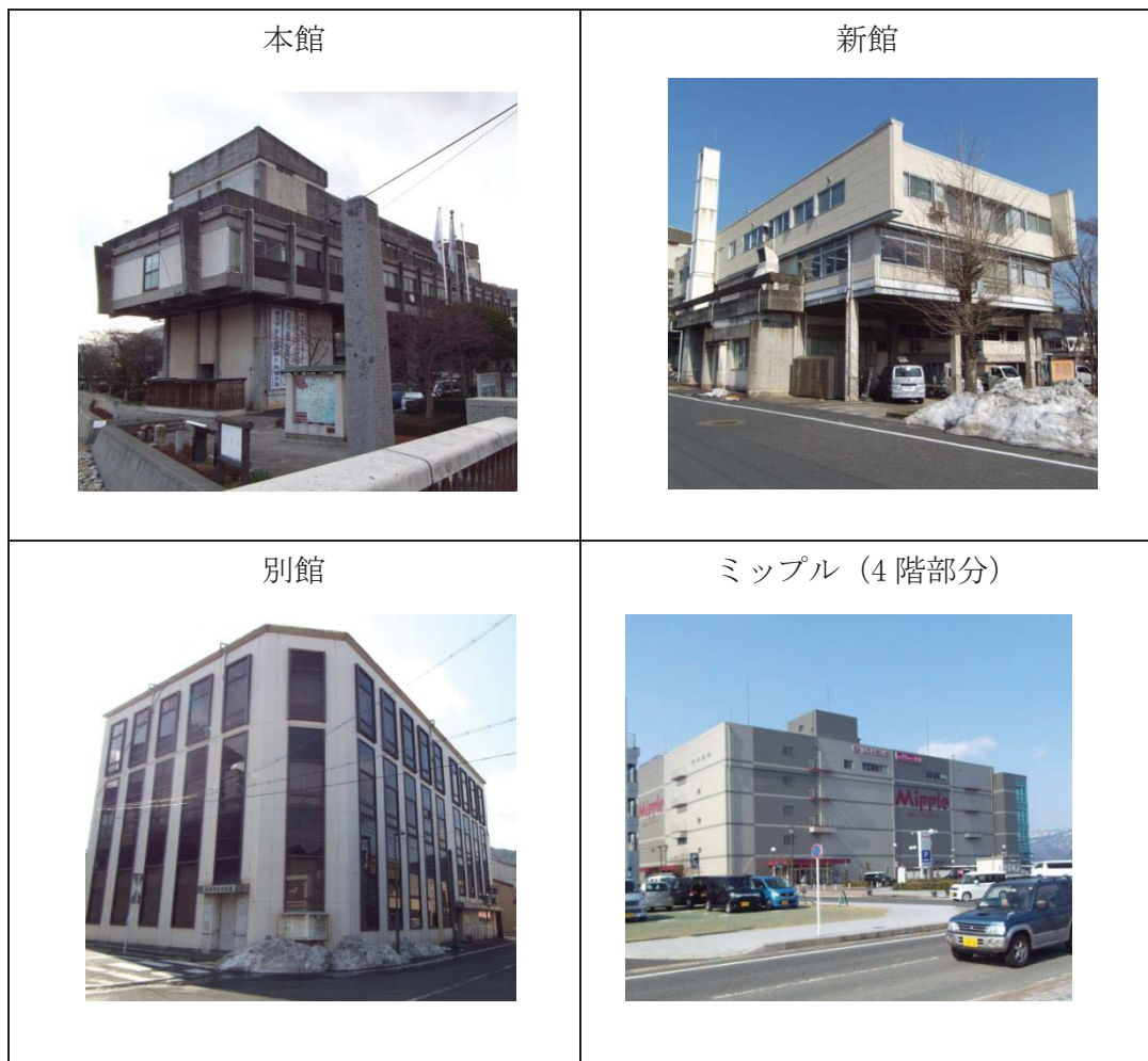
図表 市役所の外観
