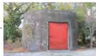
境内にある旧三井炭坑の取水塔を神輿保管庫として活用。
