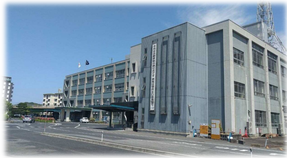
西部総合事務所 既存棟
