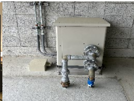
井戸さく井工事
