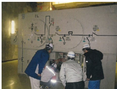
電気設備現地調査（電気主任技術者）
