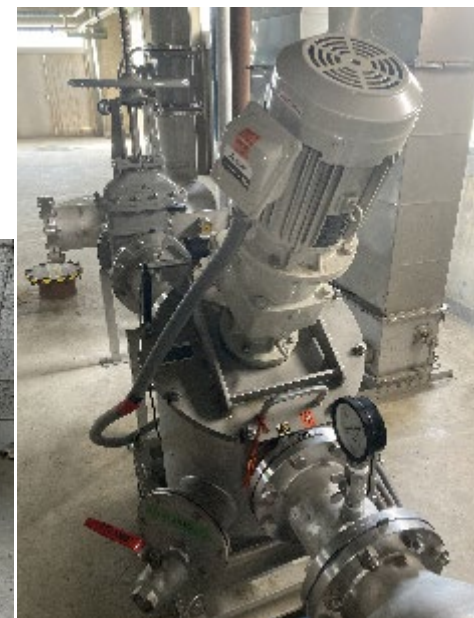
モノカッター設置（重力濃縮棟）
