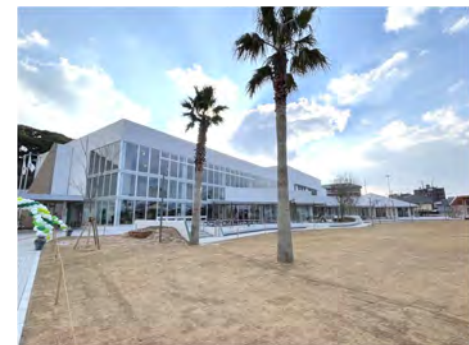
複合施設棟・外観
