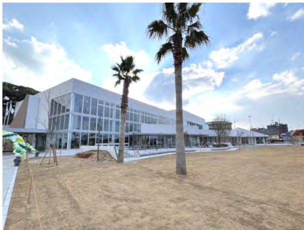
複合施設棟・外観
