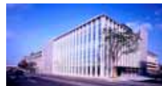
市川市立第七中学校校舎・給食室・公会堂整備等並びに保育所整備 P F I 事業
