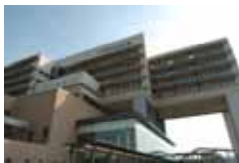
八尾市立病院維持管理・運営事業
