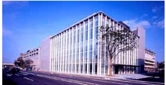
本施設は、延床面積約 23,700m<sup>2</sup>(既存校舎含む)、地上 5 階、地下 1 階の鉄筋コンクリート造(一部鉄骨鉄筋コンクリート造)、平成 15 年 9 月の本体工事着工を経て平成 16 年 9 月から施設の供用を開始しています。
