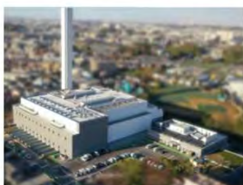
橋処理センター 神奈川県川崎市高津区新作 発電能力：蒸気タービン発電（出力12,100kW）
