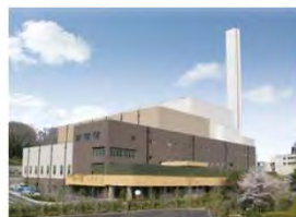
王禅寺処理センター 神奈川県川崎市麻生区王禅寺 発電能力：蒸気タービン発電（出力7,500kW）
