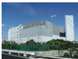
浮島処理センター 神奈川県川崎市川崎区浮島町 発電能力：蒸気タービン発電（出力7,000kW）
