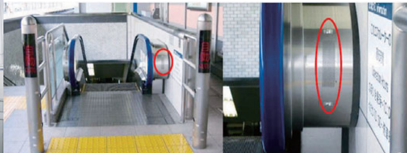
エスカレーターの音声装置（埋込型）
