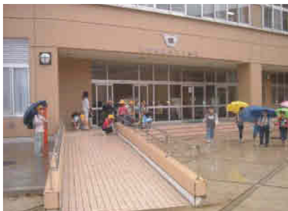
学校施設のバリアフリー化の事例（スロープの設置）
