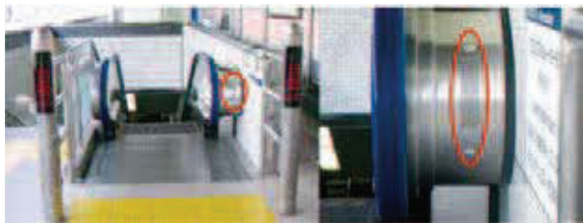
エスカレーターの音声装置（埋込型）
