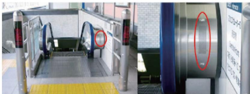
エスカレーターの音声装置（埋込型）
