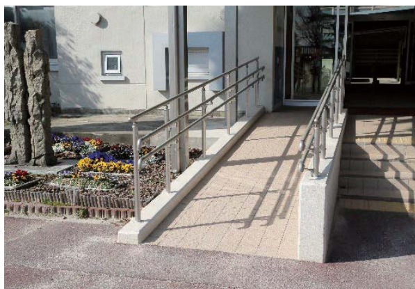
学校施設のバリアフリー化の事例（スロープの設置）
