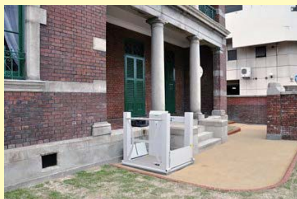
昇降機の設置
