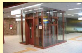
エレベーター
