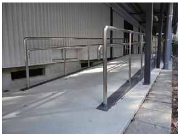
学校施設のバリアフリー化の事例（スロープ・多目的トイレの設置）
