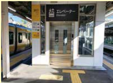
段差の解消（エレベーター）
