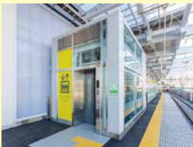
段差の解消（エレベーター）
