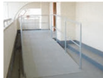
学校施設における段差解消の取組
