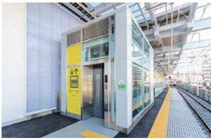
段差の解消(エレベーター)
