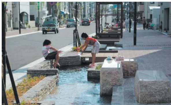
下水再生水を活用したせせらぎの創出事例 (神戸市松本地区)
