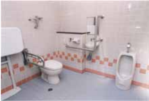
都市公園におけるバリアフリー化されたトイレ (東京都)
