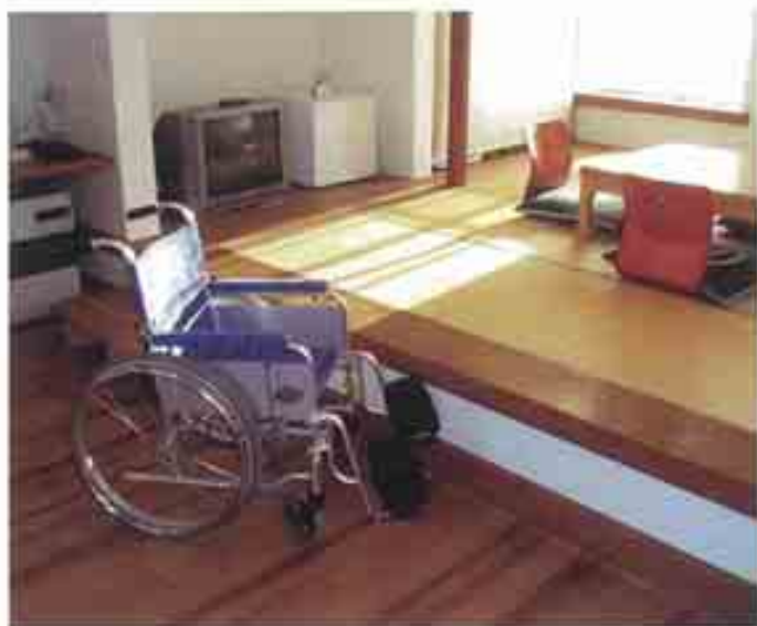
車椅子の高さに床上げされた和室
