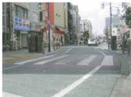
コミュニティ道路(熊谷駅北口) 車両の速度低下を図る目的で、道路をスラローム形状にするとともに横断歩道を盛り上げ歩道との段差を解消した道路整備。
