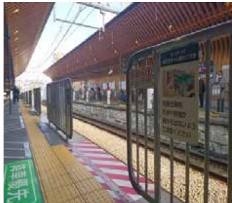
センサー付固定式ホーム柵
