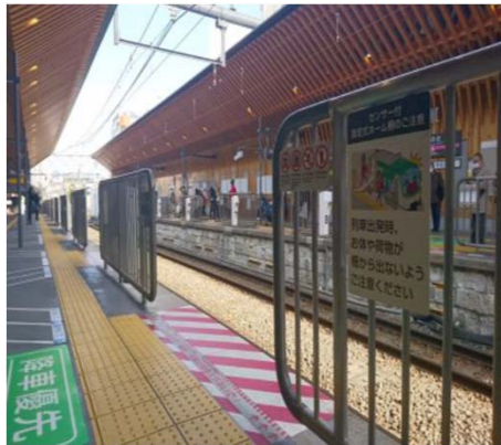
センサー付固定式ホーム柵
