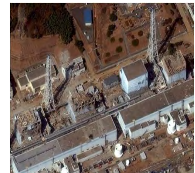
WorldView-2による被災地観測例 (福島第一原子力発電所)
