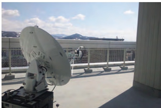
岩手県庁に設置された可搬型VSATの外観写真(アンテナ径1.0m)
